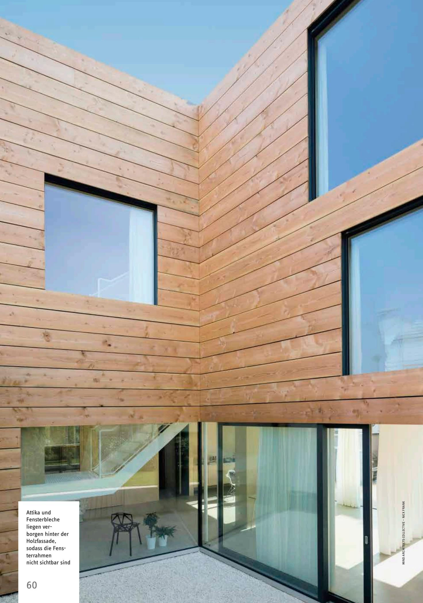
Attika und Fensterbleche liegen verborgen hinter der Holzfassade, sodass die Fensterrahmen nicht sichtbar sind
