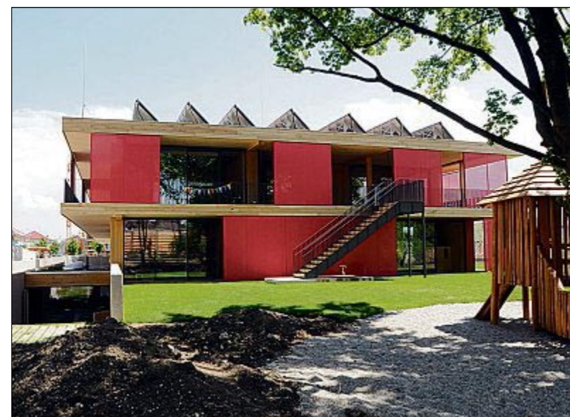
Der Neubau ist 70 Meter lang und 20 Meter breit.
