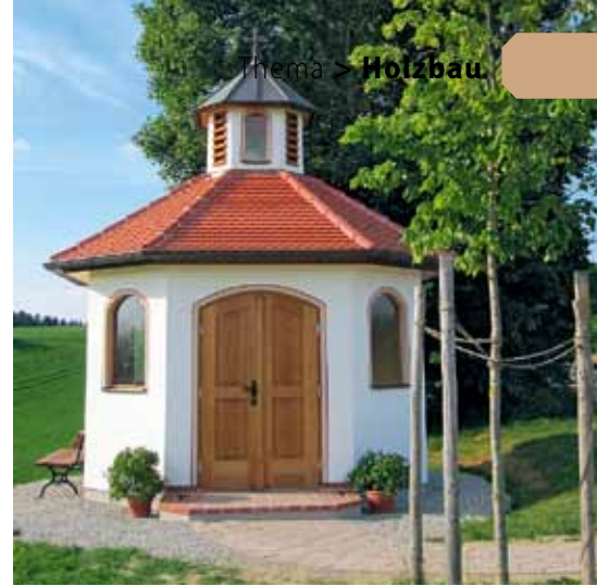
Dankeskapelle aus KLH: Die KLH-Massivholzplatten stellte ABA Holz van Kempen zur Verfügung
