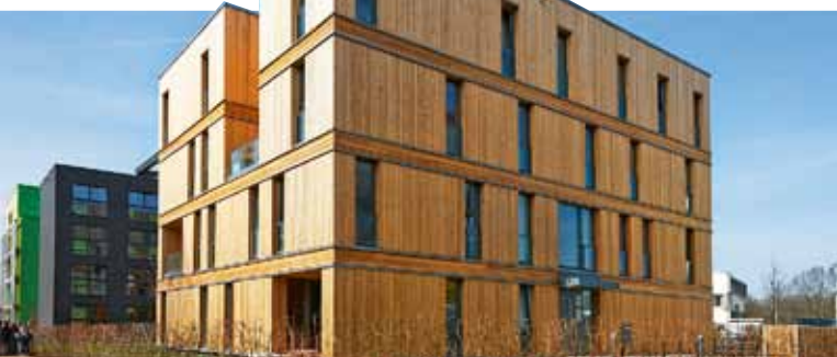
Viergeschossiger aus KLH: Auf der Internationalen Bauausstellung in Hamburg beweist ABA Holz, dass Massivholzbau auch gut nach Norddeutschland passt
