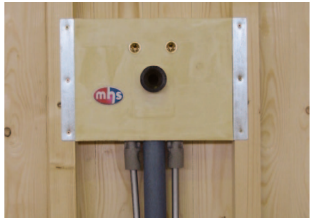
Wenn die richtige Höhe für den Wasseranschluss bzw. für den Abfluss festgelegt wurde, kann die Installationsbox mit Senkkopfschrauben auf den 5 x 8er Latten befestigt werden
