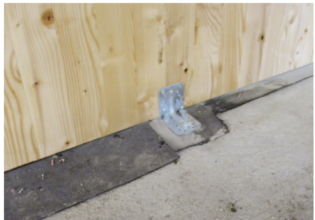
Abb. 38 - Feuchtigkeitsabdichtung
