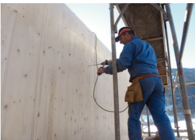
Abb. 39 bis 42 – Montage der KLH®-Elemente
