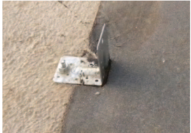
Abb. 37 – Anbringen des Montagewinkels
