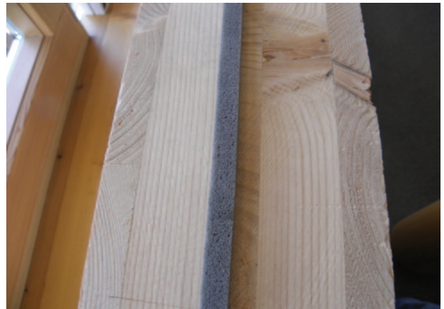
Abb. 13 - Schmales elastisches Klebeband
