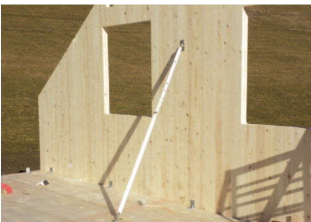
Abb. 43 bis 46 – Montage der KLH®-Elemente
