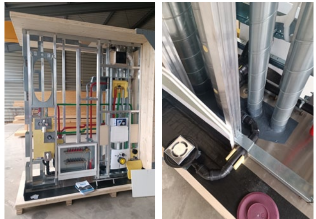
Abb. 67 - Mockup einer Systemlösung mit Abdichtungswanne
