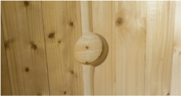
Abb. 50 - Ausfräsen der Nuten für Leitungen
