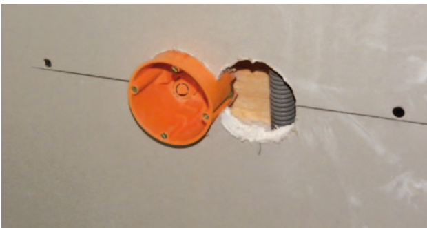
Abb. 52 - Verlegen der GKF – Platten durch den Trockenbauer, im Zuge dessen Ausbohrung der Dosen
