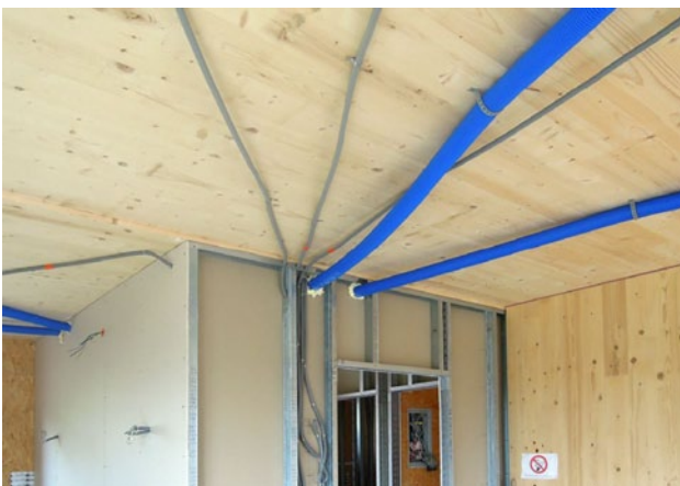
Abb. 68 - Installationsführung in der abgehängten Decke
