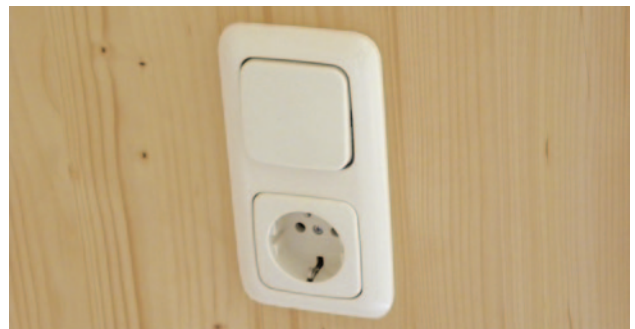
Abb. 54 - Einbau einer Steckdosen-Taster-Kombination bei Wänden mit Sichtflächen. Die Bohrung in der Sichtseite muss dem Dosendurchmesser bzw. dem Abdeckrahmen entsprechen (meist 68 mm Durchmesser)
