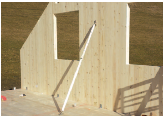
Abb. 1 - Montagestütze, Positionierungswinkel
