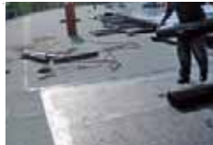
Abdichtungsarbeiten Neuburger Bautenschutz Neuburg/Kammel
