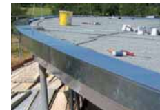
Flaschnerarbeiten BFT – Dachtechnik GmbH Bempflingen
