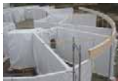
Holzbauarbeiten Holzbau Pfeiffer GmbH Remptendorf
