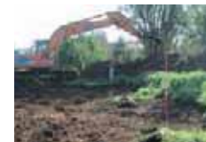
Erdarbeiten E. Bayer Baustoffwerke GmbH Esslingen
