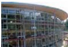
Gerüstbauarbeiten H. Single GmbH Nürtingen
