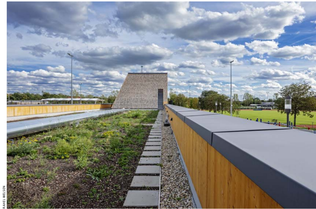
▲ Die umlaufende Attika dient auch als Überzug, der die nach innen springenden Eingangsbereiche statisch möglich macht und die Lasten aus der Decke aufnimmt
