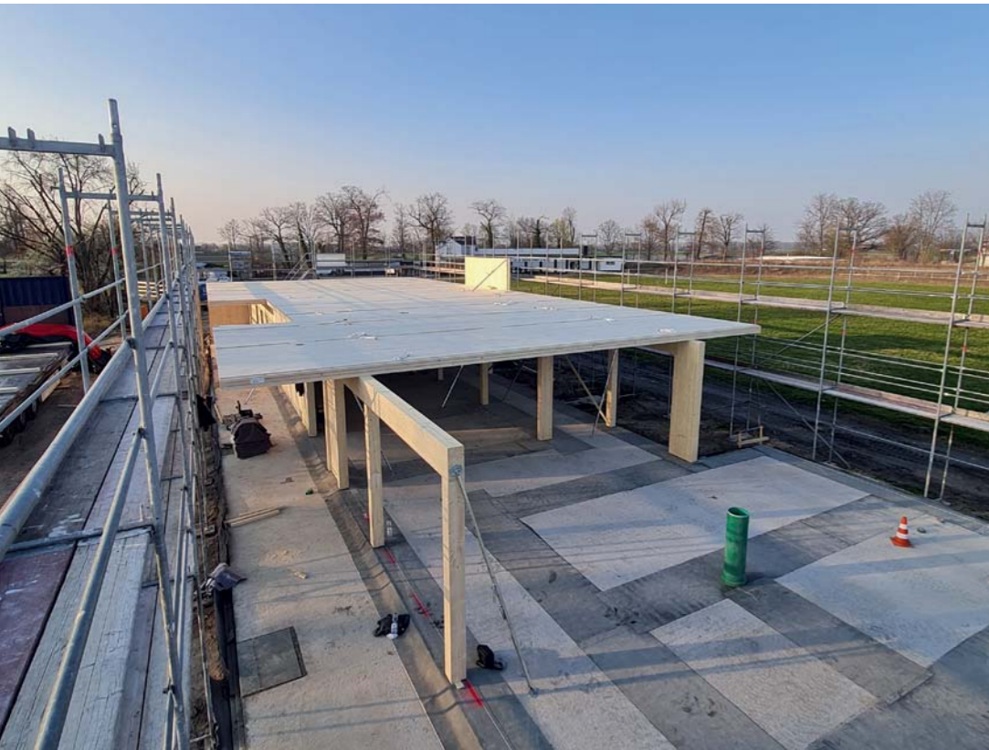
▲ Die ersten Stützen, Unterzüge und Deckenelemente sind aufgestellt
