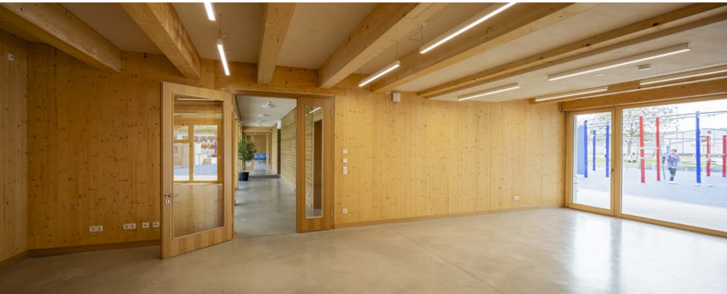
▲ Die Stampflehmwand im Flur übernimmt den Temperatenausgleich und leistet zudem akustische Unterstützung. So ist sie die perfekte Ergänzung für den Baukörper aus Brettsperrelementen
