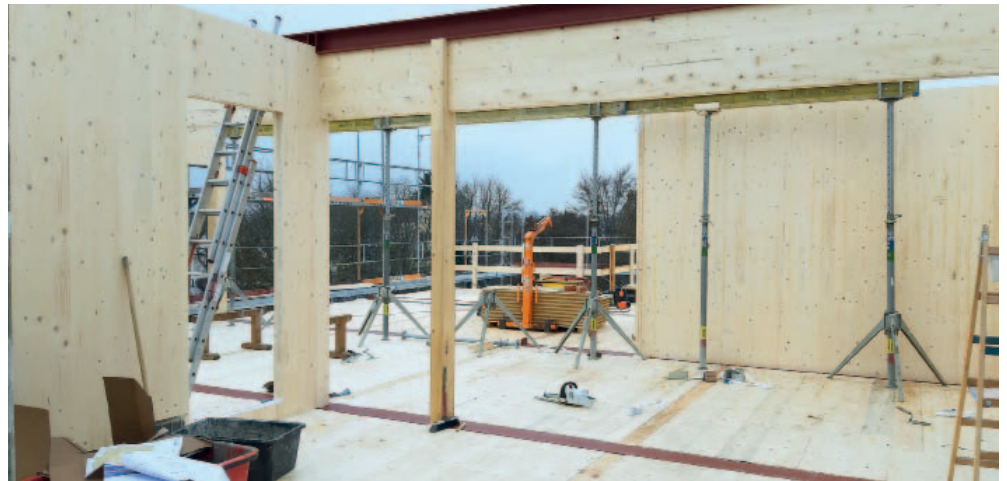
▲ Stahlträger ergänzen den Holzbau
