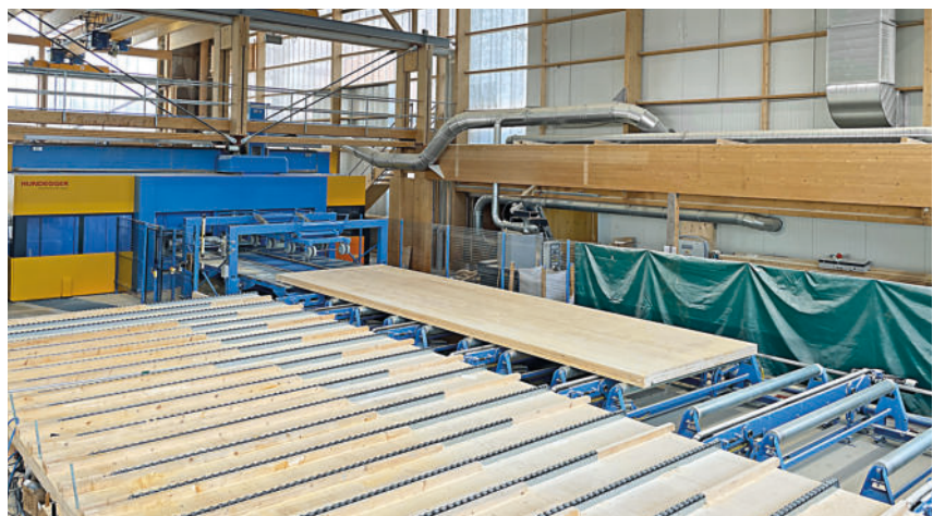
Nach erfolgtem Abbund können die BSP-Elemente auf dem Querförderer weiterveredelt werden
