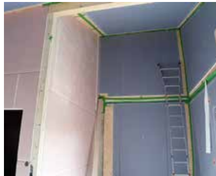
Die KLH-CLT-Innenwände wurden bereits im Werk mit stoß- und wasserfesten Hartgipsplatten beplankt.
