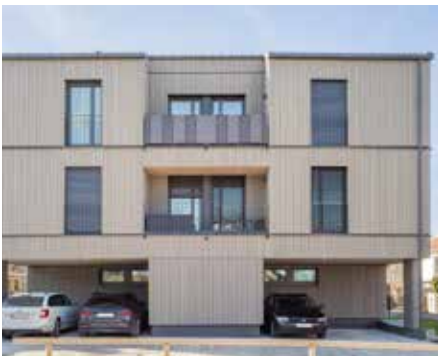
Fassadenbleche unterteilen die einzelnen Ebenen. Bodentiefe Fenster lassen viel Licht ins Rauminnere einfallen.
