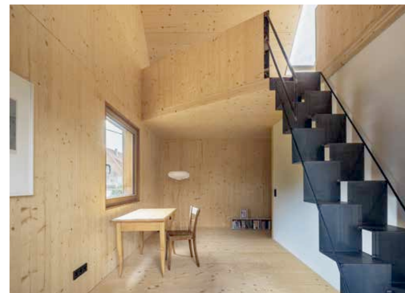
Die Massivholzwände wurden aus Tanne vorgefertigt und bieten im Sommer durch die Speichermasse ein gutes Raumklima
