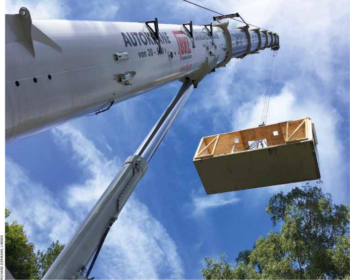
◀ Fertig montiert werden die Raumzellen anschließend auf die Lkw verladen und zur Baustelle gebracht. Dort versetzt sie ein Mobilkran zum fertigen Haus
