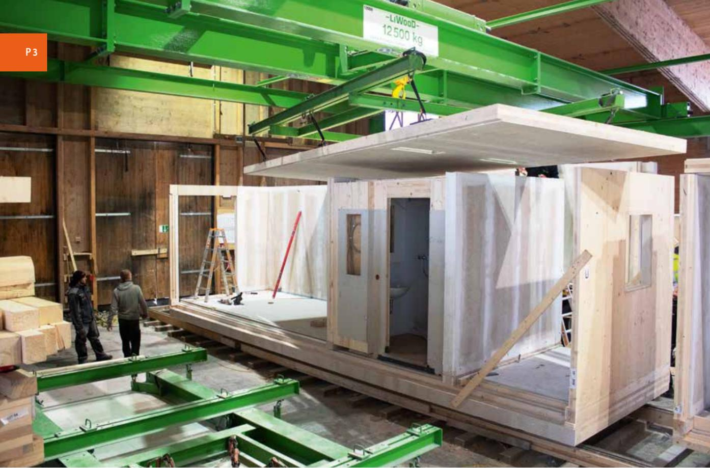
▲ Die Module aus massivem Brettsperrholz wurden in der hauseigenen Feldfabrik des GU montiert und auch komplementiert
