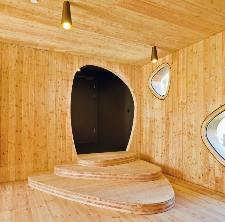
▲ Die Brettsper Holzplatten ermöglichten eine fantasievolle Gestaltung mit organischen Formen
