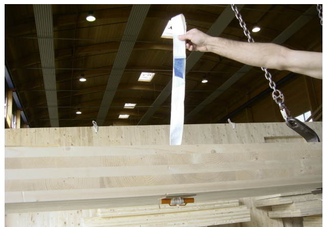
4. Hebesituation mit eingebautem FB System
