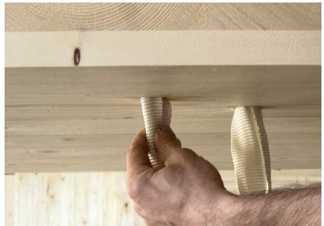
2. Schlaufe durch das zweite Loch zurückführen
