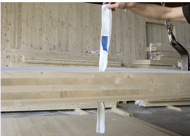
1. Schlaufe in Bohrung einsetzen
