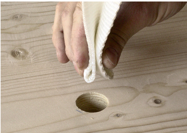
1. Hebeschlaufe in die Bohrung einsetzen
