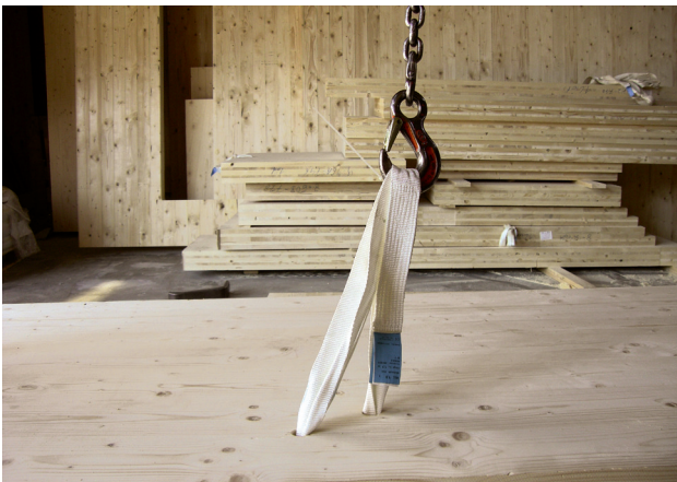
3. Hebesituation mit eingebautem FD System.
