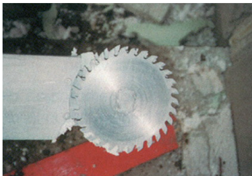
Abb. 18 - Sanierungsmaßnahme an einer zweischaligen Porenbetonsteinwand mit einem doppelseitigen Sägeblatt an einem 5 Meter langen Schwert [7.14]
