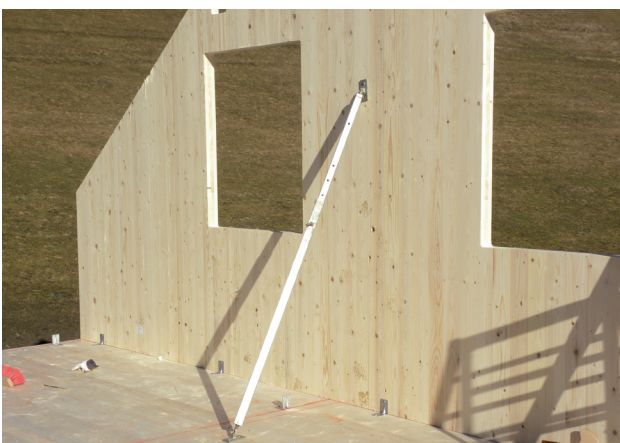
Abb. 43 bis 46 – Montage der KLH-Elemente
