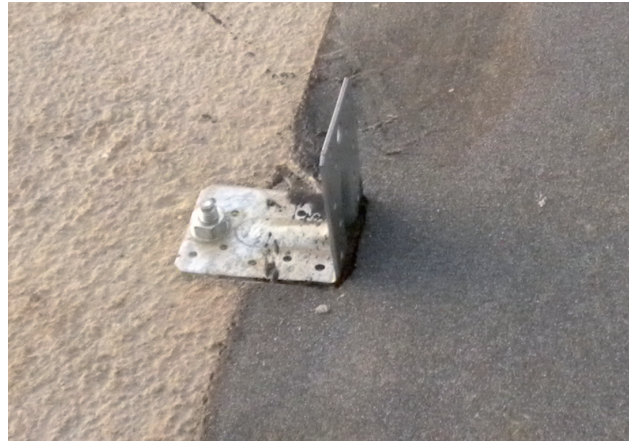
Abb. 37 – Anbringen des Montagewinkels
