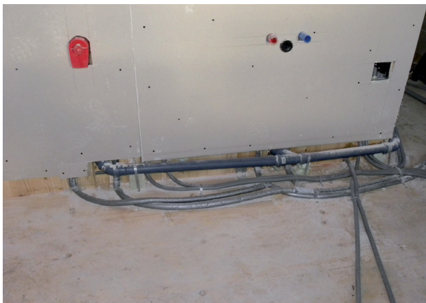
Abb. 64 - Anschluss Waschmaschine, Waschbecken
