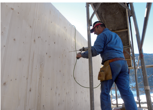
Abb. 39 bis 42 – Montage der KLH-Elemente
