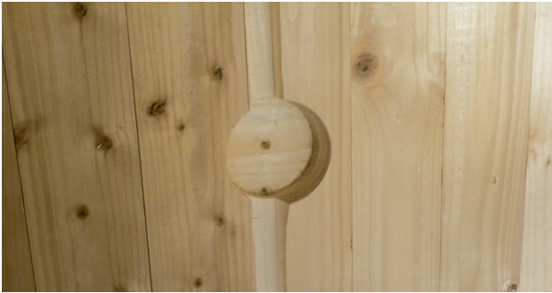
Abb. 50 - Ausfräsen der Nuten für Leitungen
