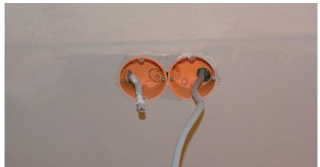
Abb. 53 – Einsetzen und Fixierung der Dose (Elektriker)
