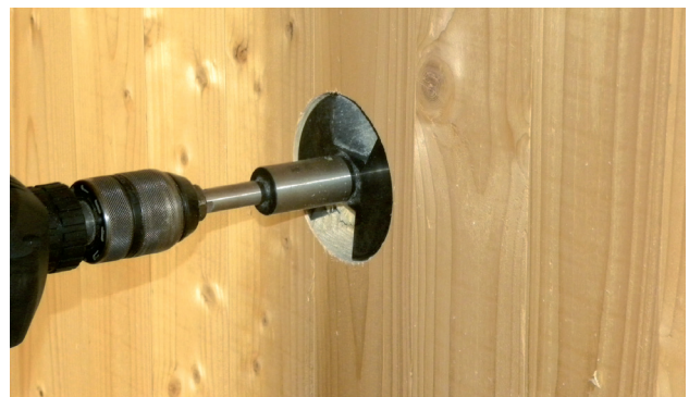
Abb. 49 – Steckdosenbohrung in einer KLH-Nichtsichtwand
