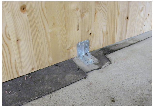
Abb. 38 - Feuchtigkeitsabdichtung
