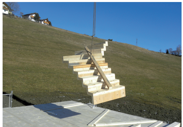
Abb. 48 - Montage Fertigteilstiege
