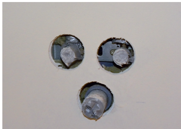
Abb. 69 - Wasser- und Abwasseranschluss
