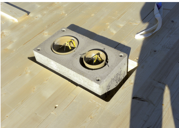
Abb. 47 - Montage Fertigteilkamin
