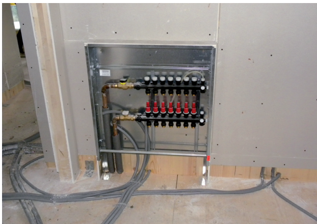
Abb. 66 - Stockwerksverteiler
