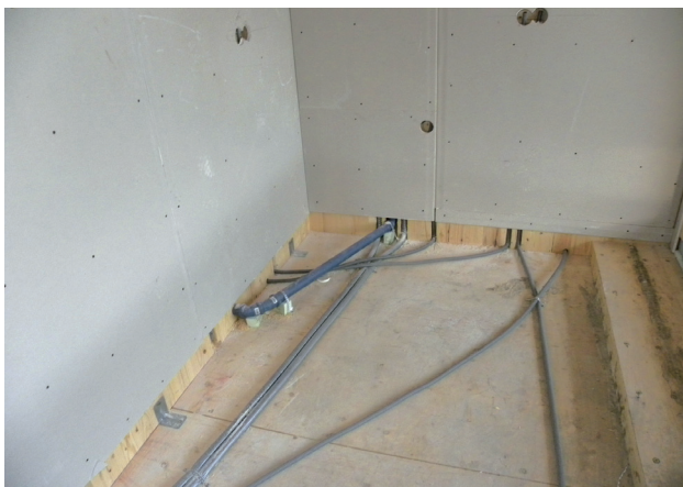
Abb. 68 - Leitungsführung im Bodenaufbau
