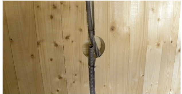
Abb. 51 – Installation der Leerverrohrung z.B. mit einem 25 mm FX Schlauch (Elektriker)
