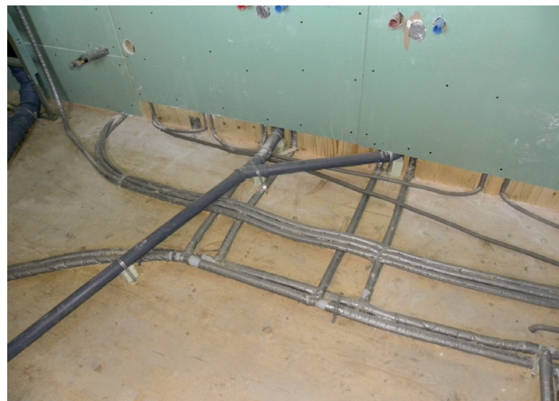
Abb. 65 - Anschluss Doppelwaschbecken
