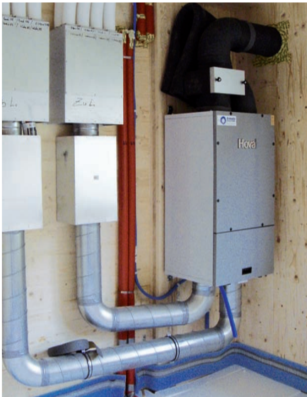
Abb. 13: Montage einer Lüftungsanlage an einer KLH-Wand [mit freundlicher Unterstützung durch Eberle • denkfabrik •, Dornbirn, Österreich]
